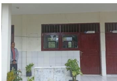
Gambar 8. Tampak luar perpustakaan SDN Buraen 1
